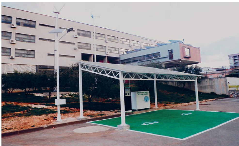
Solarna punionica
