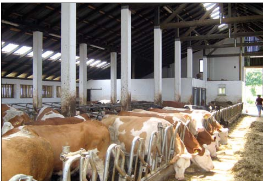
Vidljiva je i krmna zabrana, a i krovište građeno u tipu koje osigurava svjetlost i ventilaciju
