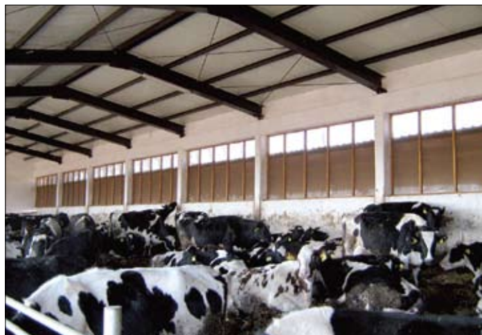
Na zivodima uočljivi prozori u funkciji ventilacije. I visina i krovšte,
