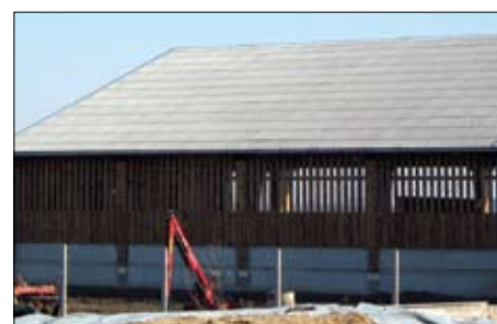
Jednostavni rešetkasti zid štale
