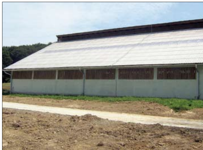
Tzv. rolete ispune osiguravaju i svjetlost i ventilaciju
